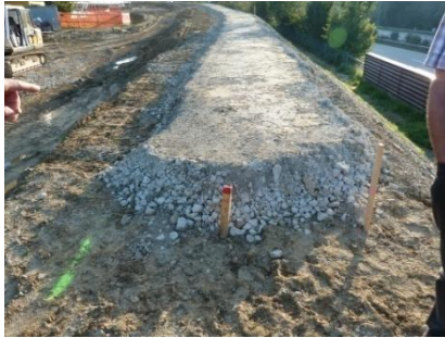
Verdichtete Kiestragschicht
