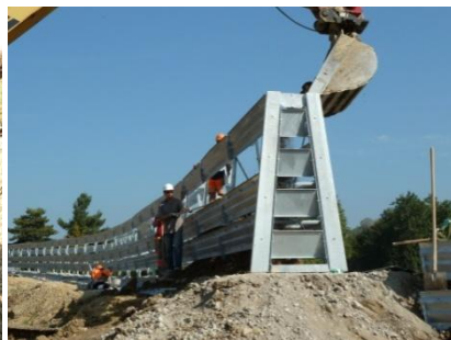
Befüllen mit Bagger
