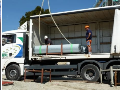
Abladen per Kran oder Stapler
