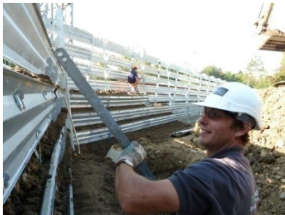
Setzen der Anker
